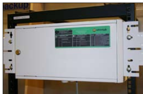
BAS XM monterad i 19" stativ med medföljande 19" vinklar.
