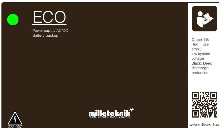
Taulu 10. Hälytys näkyy kaapin ovessa / merkkivalo.
